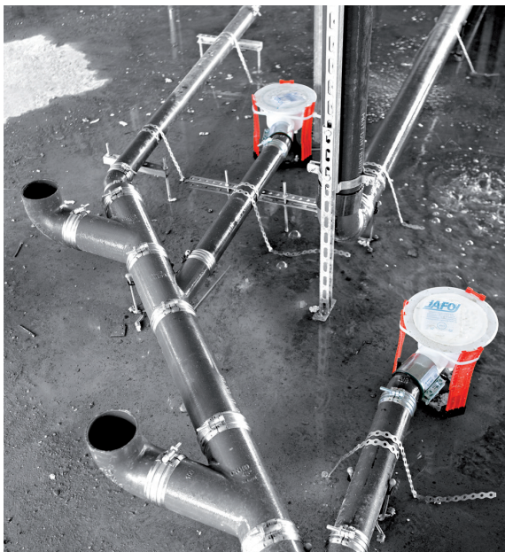
Exempel på montage av golvsbrunn på betongbjälklag med JAFO Golvsbrunnfixtur ▼
